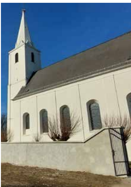
In Schattendorf wird die Kirchenhofmauer saniert.
